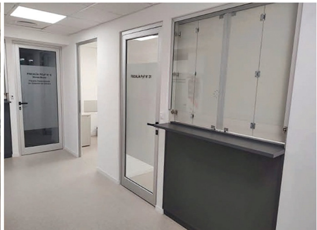
Obras de remodelación en Avenida Córdoba 820.
